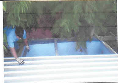
Foto 6: Cambio de cocina de madera por cocina de block co costaneras de metal y lamina troquelada 26"
