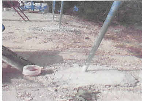
Foto 2: Cambio de cerco de maya con madera, por cerco de maya con tubo galvanizado.
