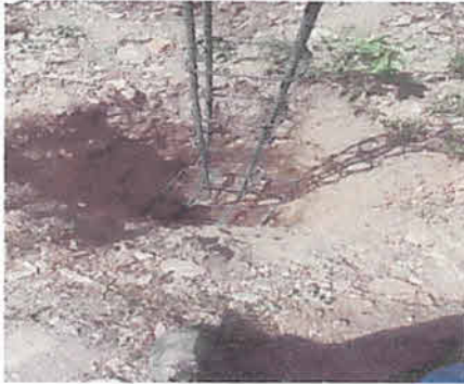
Foto 1: Cambio de cerco de maya con madera por cerco de maya con tubo galvanizado
