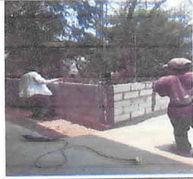
Foto 4: cambio de cocina de mandera por cambio de cocina de block con costaneras de metal y lamina troquelada 26"
