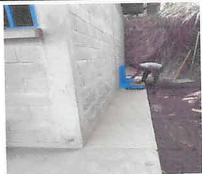
Foto 5: cambio de cocina de madera por cocina de block con costaneras de metal y lamina troquelada 26"
