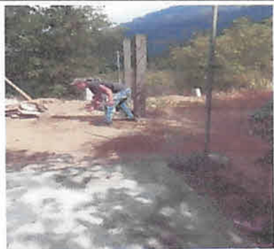
Foto 3: Cambio de cerco de maya con madera, por cerco de maya con tubo galvanizado
